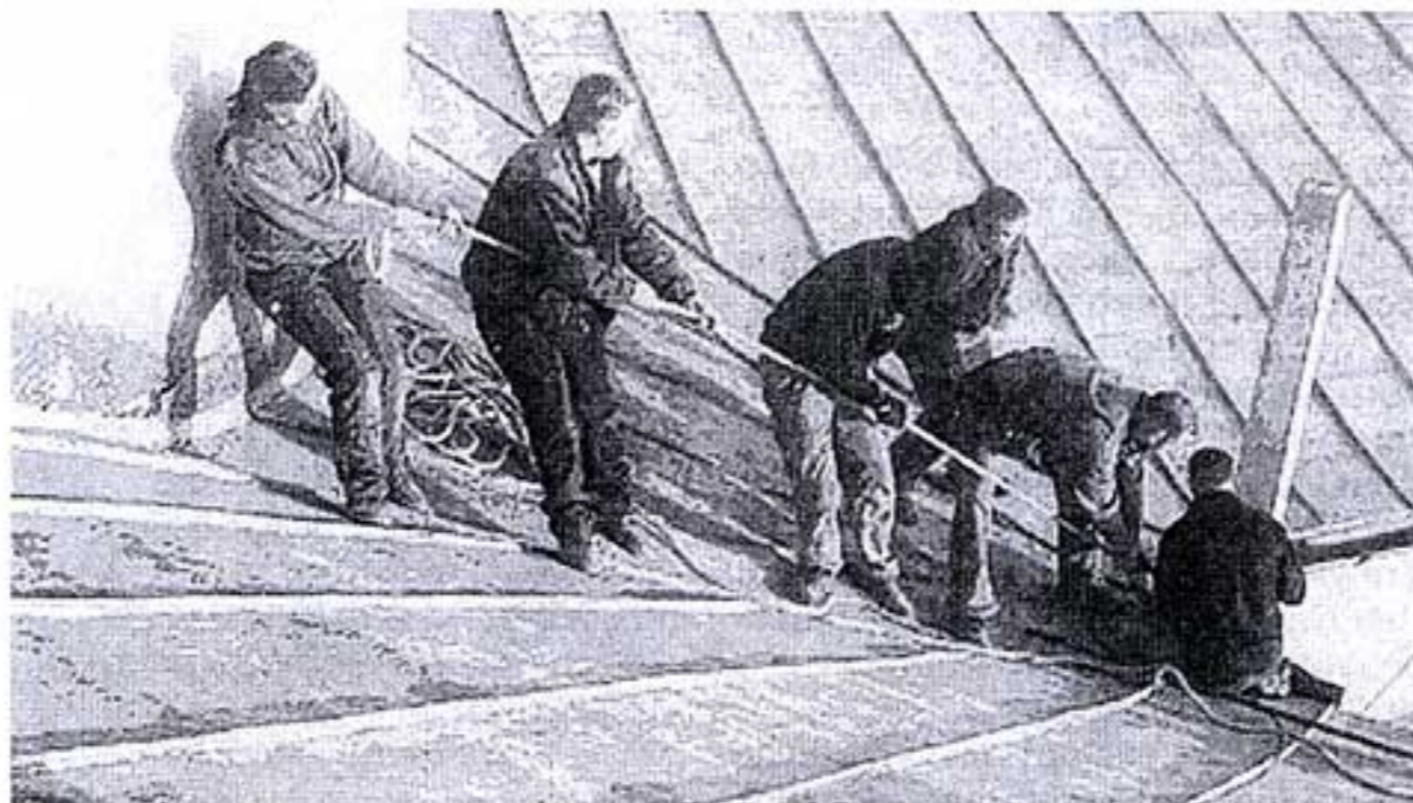
In vorbildlicher Teamarbeit reparierten Meisterschüler der Robert-Mayer-Schule, Stuttgart, das Dach des Domes von Oradea/Palota.
